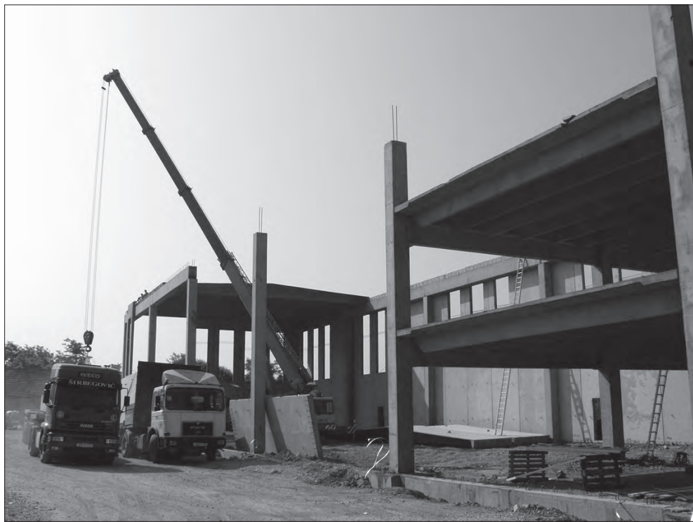
Proizvodna hala "Variplasta" u izgradnji. Snimio R. Kapetanović
