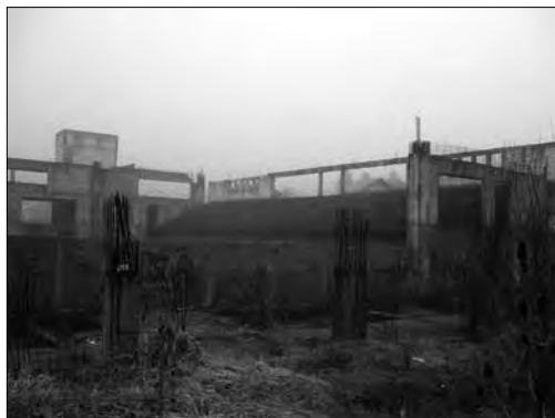
Objekat PKSC-a u izgradnji
