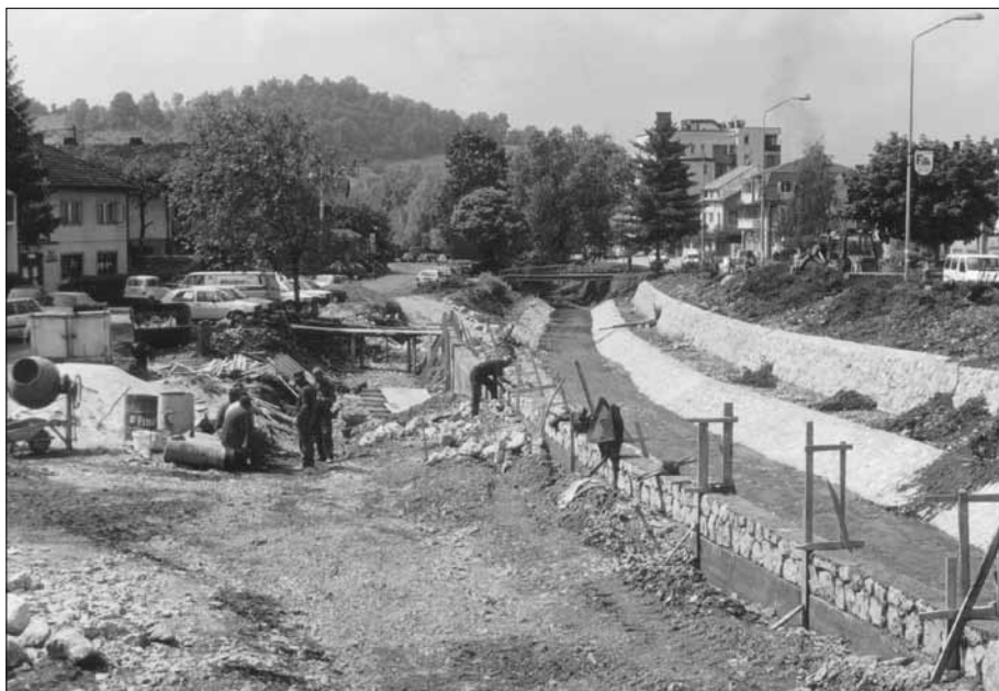
Radovi na regulaciji rijeke Sokoluše, detalj
