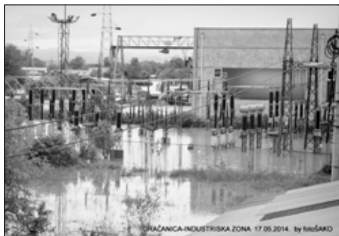
Slika 3 – Trafo stanica sagrađena u plavnom području rijeke Spreče u Gračanici
