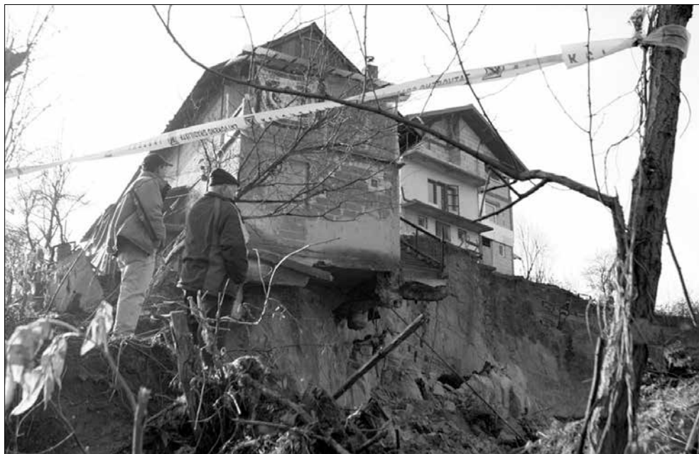
Slika 4 – Klizište posljedica divlje gradnje u Crvenim Njivama u Tuzli
